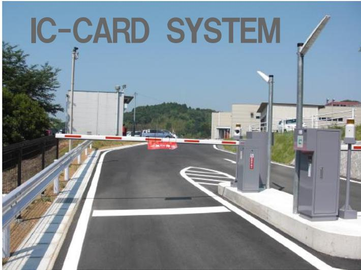
入口/出口の機器にカードをかざして通過するシステム
