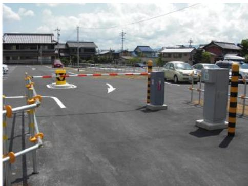
カード読取部は非接触のため機械的な故障が少なく低コストで運用ができます。
